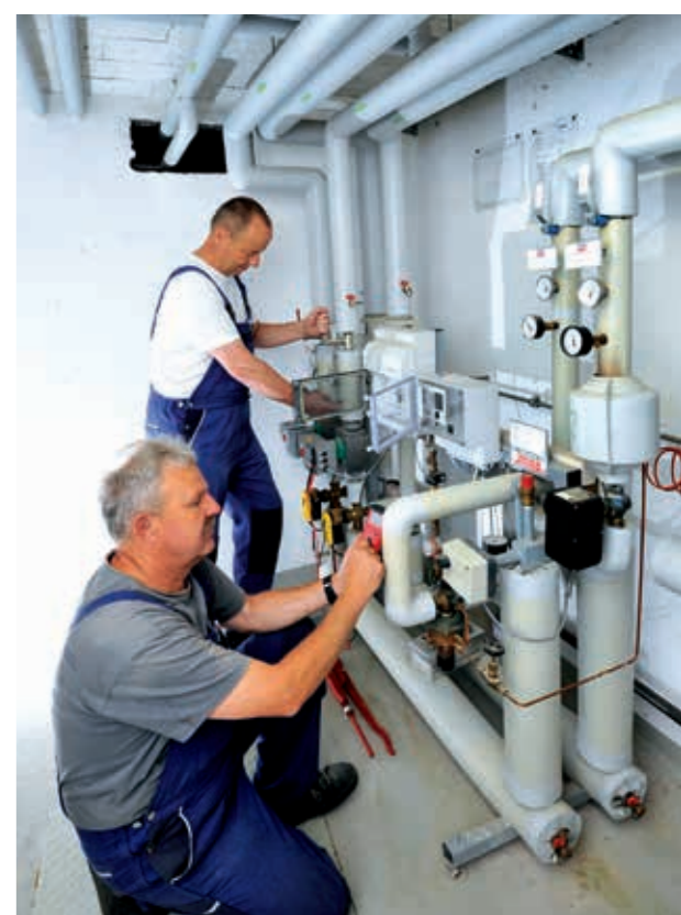
▲ Die Kundendienstmonteure Lutz Börnich (vorn) und Reinhard Fischer von der Firma Sell GmbH bei Überprüfungs- und Wartungsarbeiten an einer Hausanschlussstation
