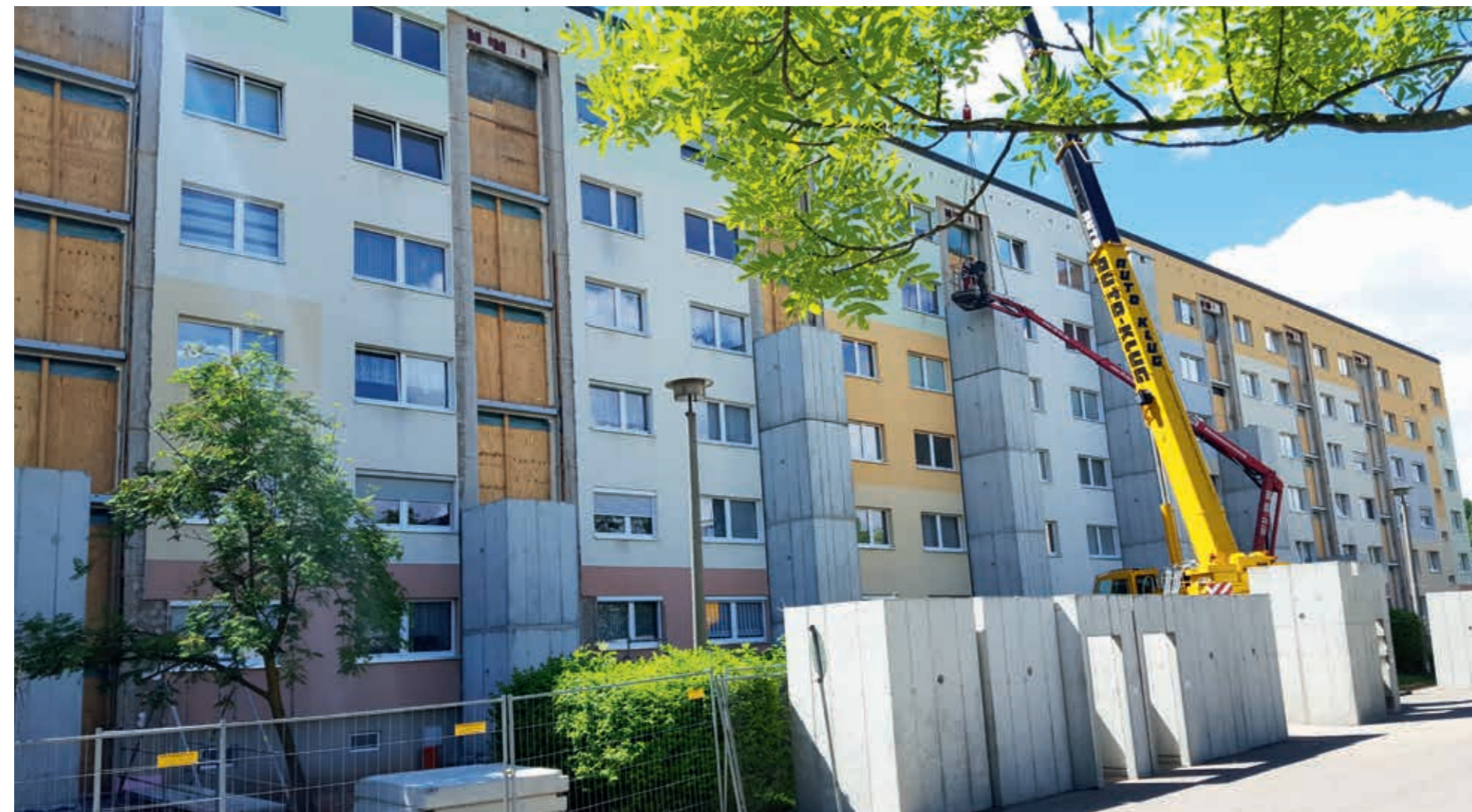
◀ Am Großblock Südstraße 23 - 32 werden zehn Aufzüge angebaut
